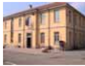
Scuola Elementare Ada Negri - Locali Refezione Motta Visconti (Milano)
